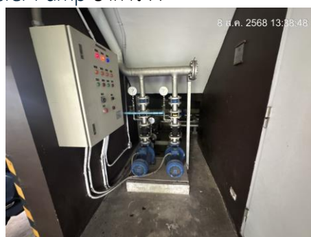
ถังเก็บน้ำสำรอง ใต้ดิน และ Transfer Pump อาคาร B
