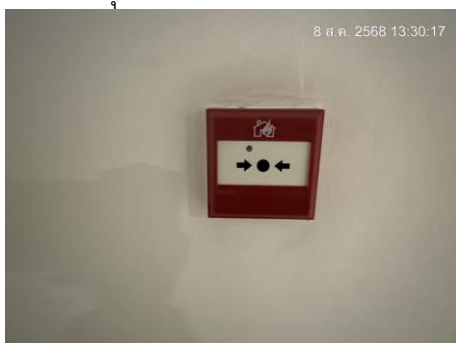
อุปกรณ์แจ้งเหตุด้วยมือ รูปที่ 2.1-14 ระบบป้องกันอัคคีภัย
